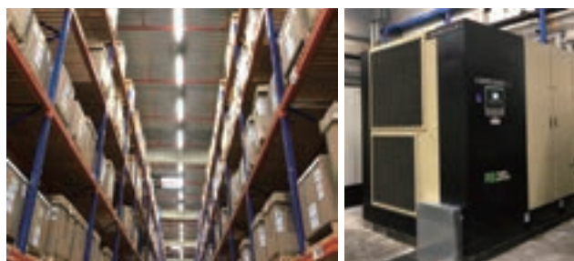
LED照明採用・トナー製造用コンプレッサ高効率化によるエネルギー消費量削減 東芝テックヨーロッパ画像情報システム社
