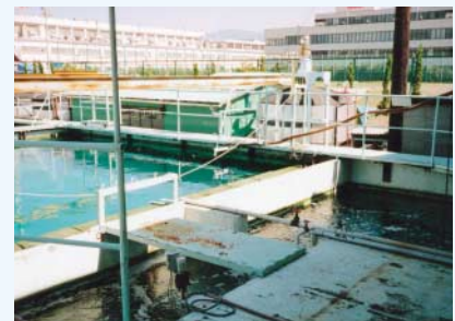
三島事業所、旧産業廃水処理場
