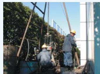
監視井戸掘削状況
