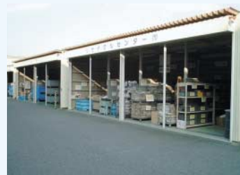
リサイクルセンター( 秦野工場 )
