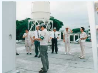
現場監査風景
