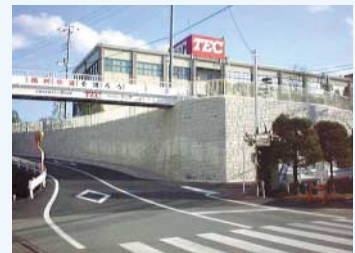
公道に隣接した石垣改修
