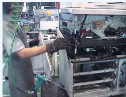
手作業による解体
