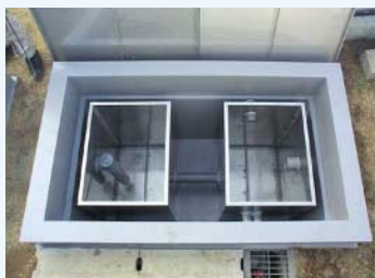
2重構造の油水分離槽
