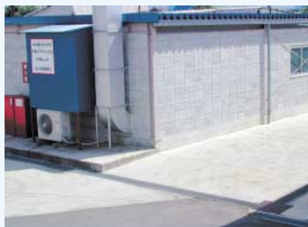
危険物倉庫周辺グレージング
