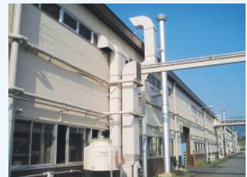
配管の地上化
