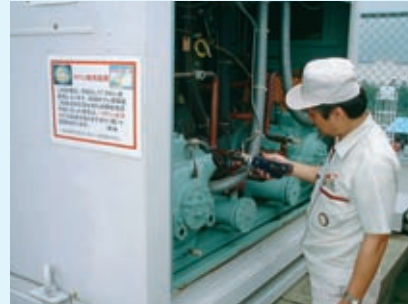
フロンガス測定状況
