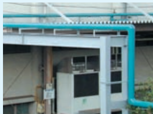
配管地上化 (三島)
