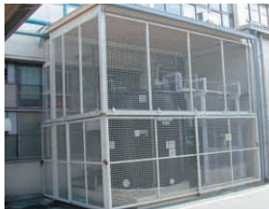
危険防止の囲いと屋根を設置
