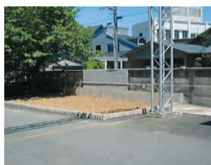
重油下段タンク撤去後
