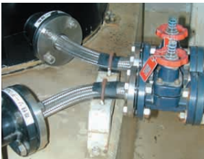
配管をフレキシブル構造に改善
