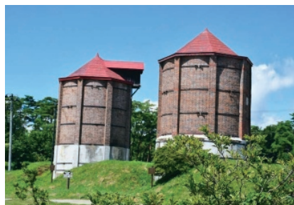
▲「重要文化財」コースでは、日本に現存する最古の煉瓦造りサイロ(写真)や、明治時代に建造された天然冷蔵庫などを回る(写真提供/小岩井農場株式会社)
