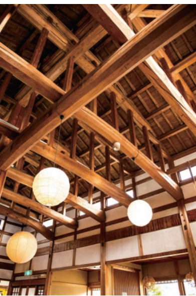
▲太い梁が縦横に張りめぐらされた吹き抜けの天井
